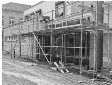
Sanierung Vordach Grundschule Moritzburg
