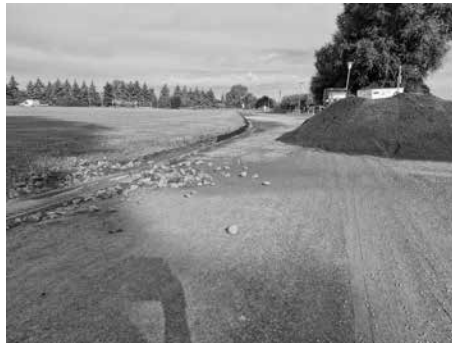
Erneuerung Laufbahn Sportplatz TSV Reichenberg/Boxdorf
