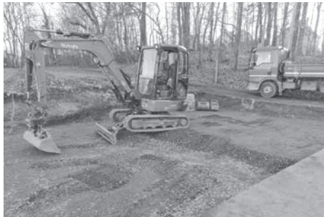
Bauvorbereitung für den „Nahkauf“ in Friedewald
