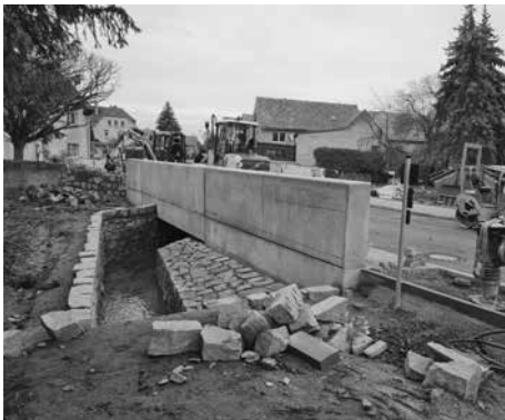
Neues Brückenbauwerk über Bindebach
