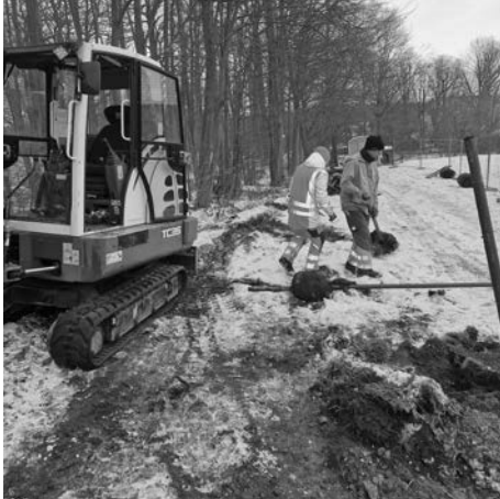
Vorbereitende Arbeiten durch den Bauhof – Schulweg OT Auer
