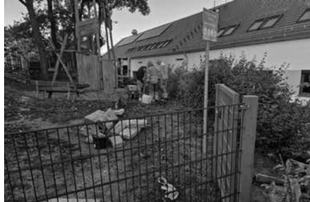
Geländesicherung der Grundschule Moritzburg
